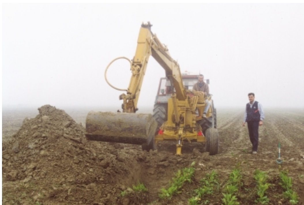
Il tecnico Travaglia con l'operatore Marzolla all'inizio dello scavo
